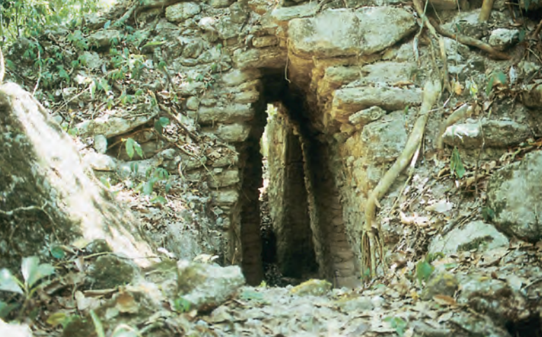
V skalno podlago izkopan zbiralnik za vodo (čultun).
