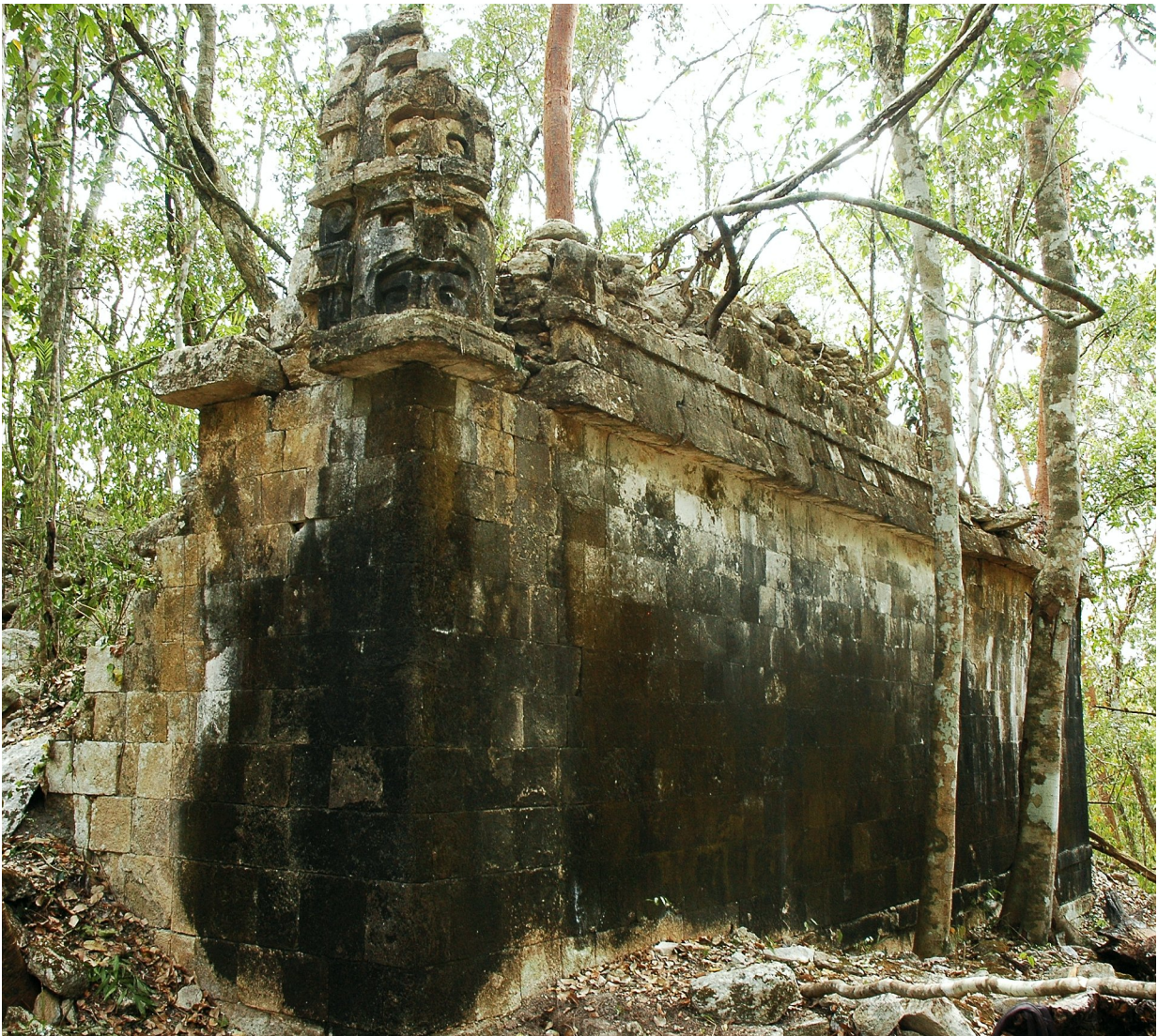
Figura 3.7. Grupo F26-b, estructura en el lado oeste de la plaza sur, vista hacia el suroeste.
