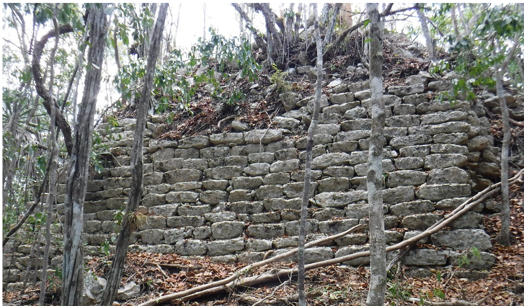
Figura 3.15. Grupo F26-e, estructura este, talud norte.
