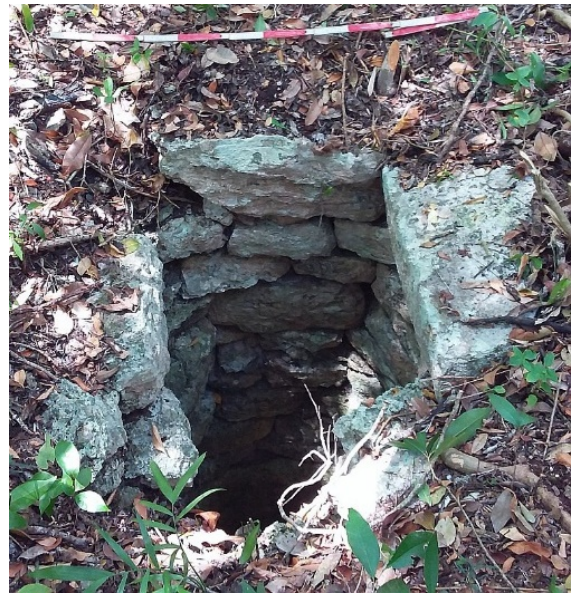
Figura 3.11. Chultún ubicado entre los grupos F26-c y F27-a.
