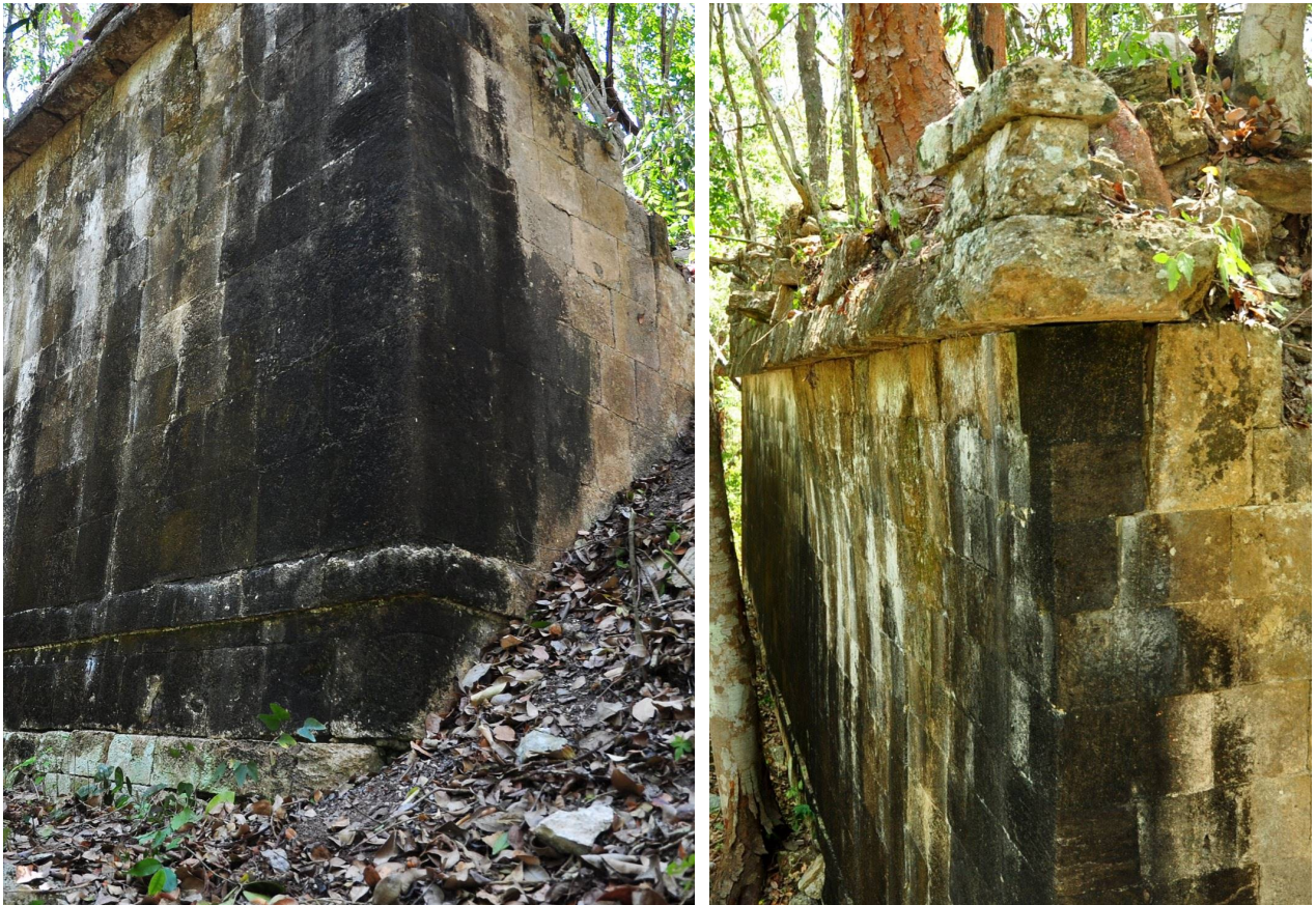
Figura 3.9. Grupo F26-b, estructura en el lado oeste de la plaza sur, esquina noroeste.
