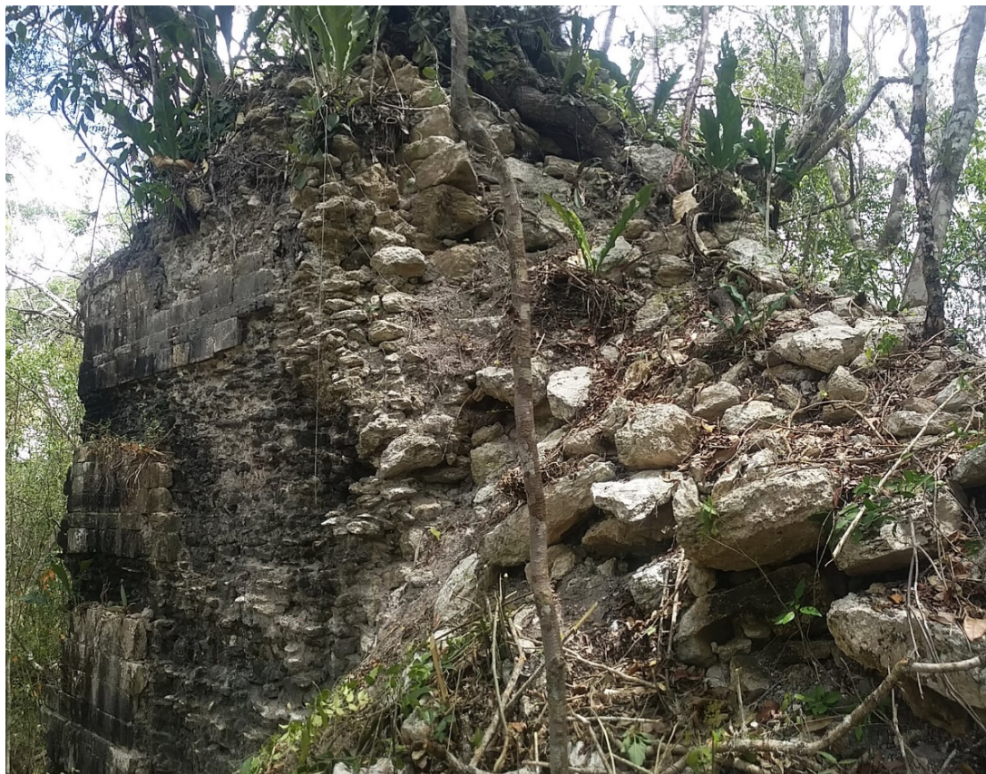
Figura 3.35. Grupo H31-e, parte poniente del edificio con dos torres, vista hacia el noroeste.
