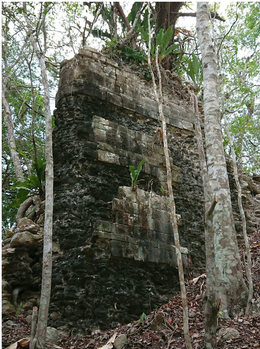
Figura 3.34. Grupo H31-e, edificio con dos torres, fachada sur de la torre poniente.
