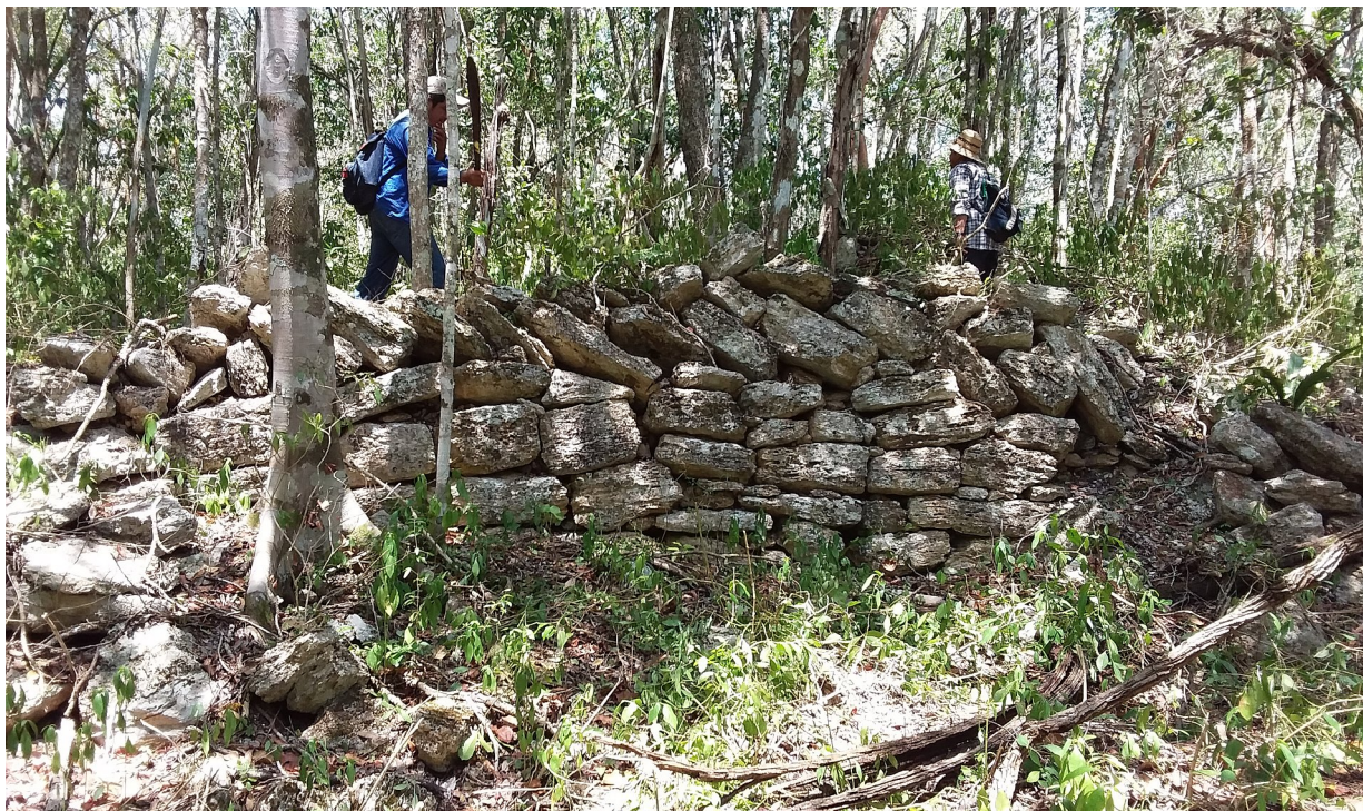
Figura 3.41. Grupo K29-d, muro de contención en el lado oriente del grupo de patio, vista hacia el poniente.
