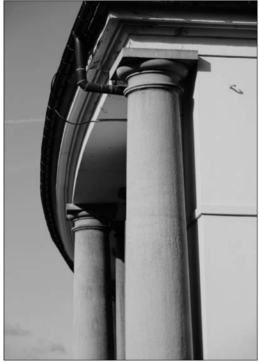
Del ostrejša z novimi bakrenimi žlebovi, oktober 2006 (foto: Damjan Prelovšek)
